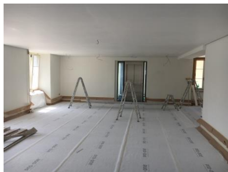
Das 1. Obergeschoss mit der neuen Gipsdecke
