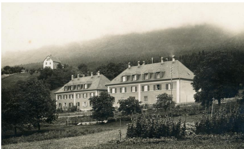
Arbeiterwohnen um 1920, Bernoulli-Häuser an der Rebgasse
