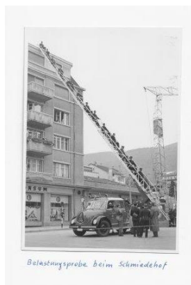
Belastungsprobe der Leiter des neuen Feuerwehrautos beim Schmiedehof, 1957, STaG
